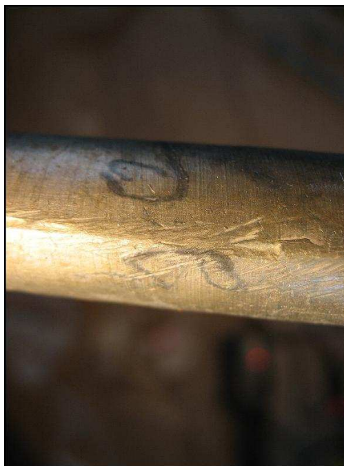
Figura 58 – Detalhe da solda do Tubo Fonte: Acervo fotográfico do autor.
