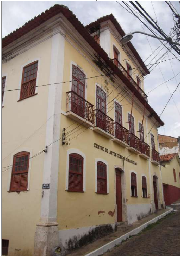
Figura 3 - Sede 03, Solar da Baronesa de São Bento / Rua Santo Antônio, Centro de São Luís, MA
