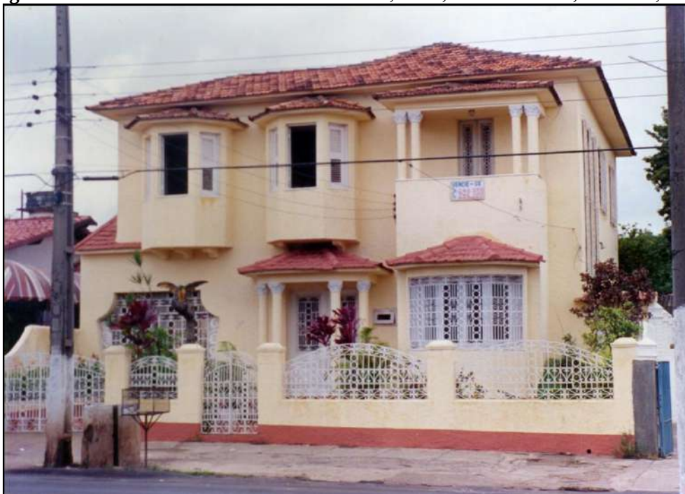
Figura 1 - Sede 01 da EMEM / Av. João Pessoa, nº 44, Monte Castelo, São Luís, MA
